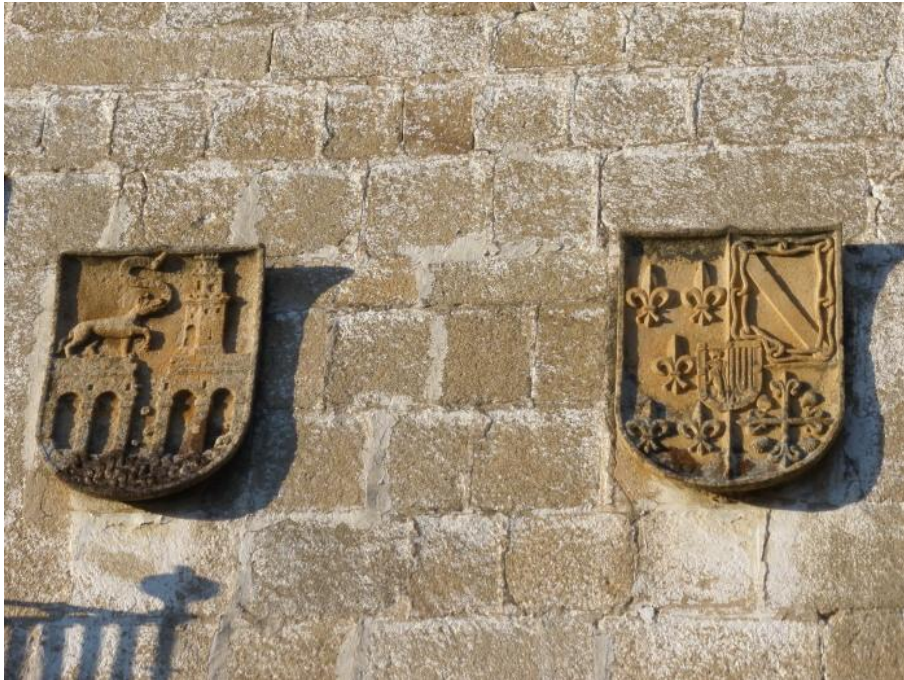
Palacio de los marqueses de Torreorgaz. En el centro de la fachada, los escudos de los Aponte (izquierda) y el otro con cuarteles de los Aldana, Zuñiga, Ovando y Rocha.
